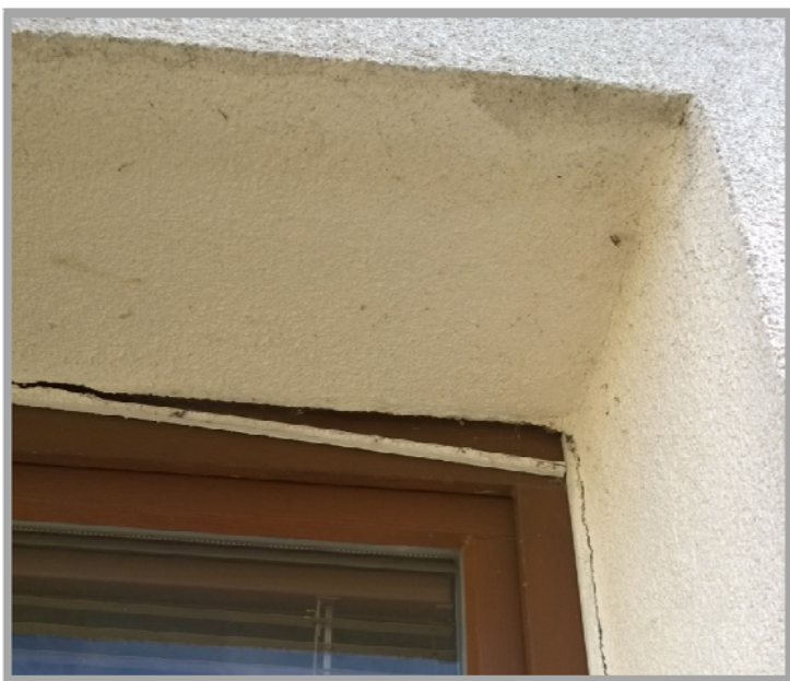
Obrázek č.3: (trhlina pod oplechováním)
