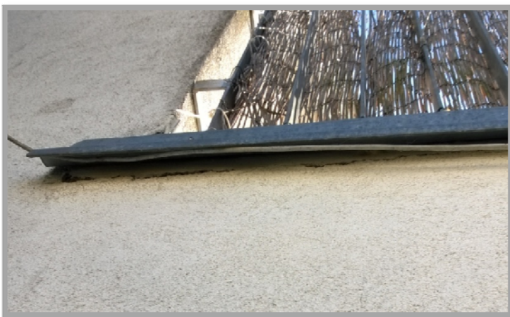
Obrázek č.3: (trhlina pod oplechováním)
