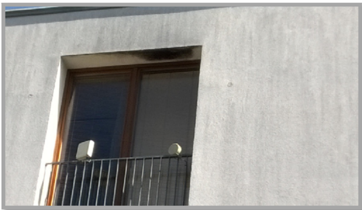
Obrázek č.2: (Održený připojovací profil)
