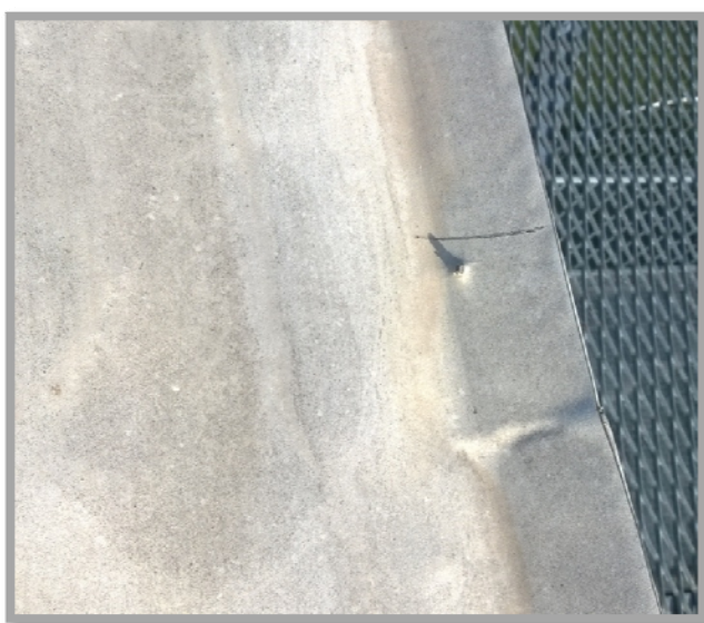
Obrázek č.11. : (Detail proniku šroubu)
