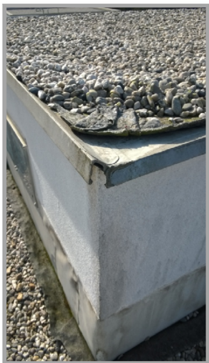
Obrázek č.6. : (Detail na oplechování střešní nástavby)
