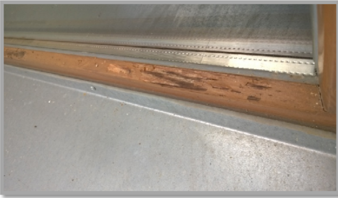
Obrázek č.3: (chybějící okapnička)
