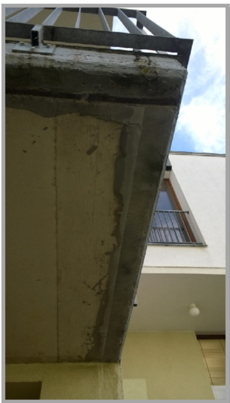
Obrázek č.2: (poškozená krycí betonové vrstva podhledu s pokusem o sanacaci)
