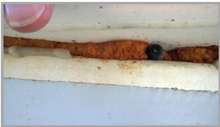
Obrázek č.7. : (detail u výlezu na střechu)
