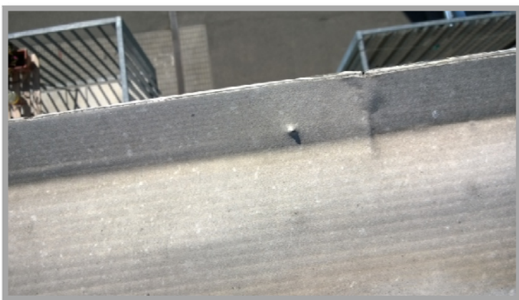
Obrázek č.6. : (Samořezný šroub skrz oplechování)
