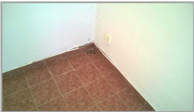
Obrázek č.9: (odpadlé soklové dlaždice)
