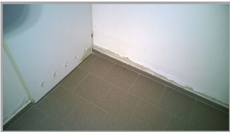
Obrázek č.9: (odpadlé soklové dlaždice)
